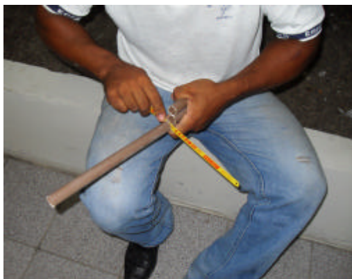
Figura 4 Corte dos canos de PVC.
