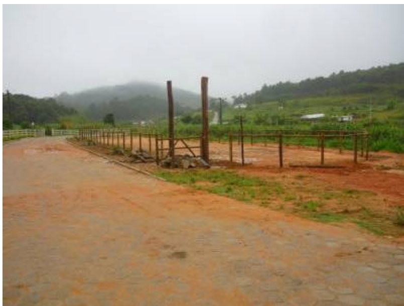
Figura 9: Vista da construção do “Coliseu” Fonte: Acervo do autor.
