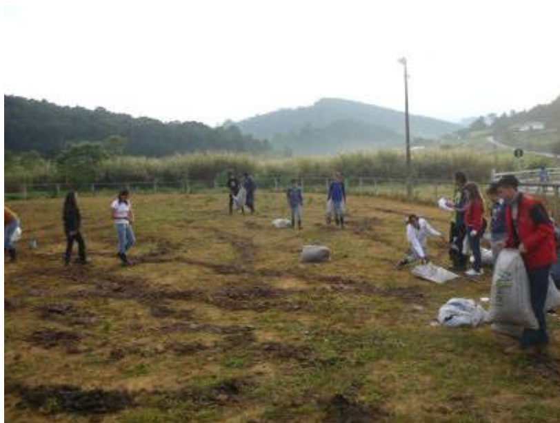
Figura 5: Obras para a construção das Pistas. Fonte: Acervo do autor.
