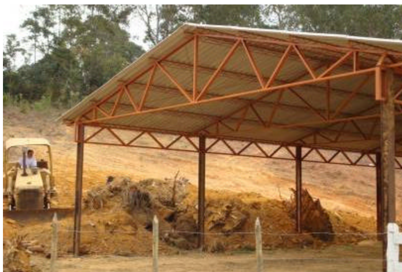
Figura 6: Terraplanagem para a construção das Pistas Fonte: Acervo do autor.
