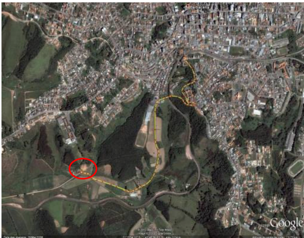
Figura 3: Imagem de Satélite (29/03/2006) do local escolhido para o Centro de Equoterapia, com tracejamento desde a entrada principal da Instituição. Fonte: Google Earth 2010.
