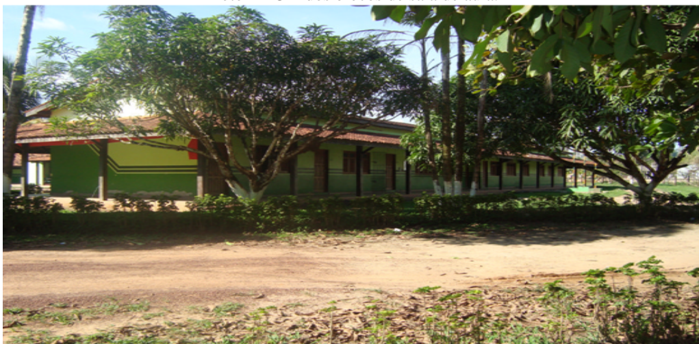
Foto 2 - Um dos blocos de sala de aula.
