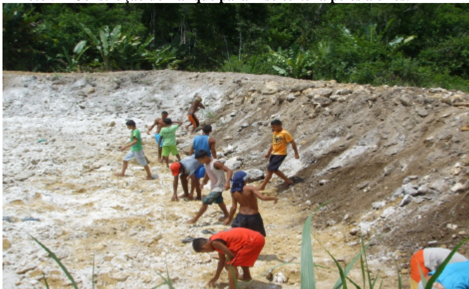
Foto 5 – Construção do Tanque para Piscicultura pelos alunos.
