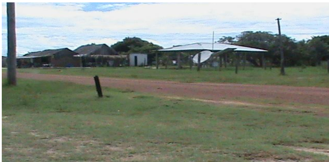
Figura 05 - Antenas do GESAC e de telefonia
