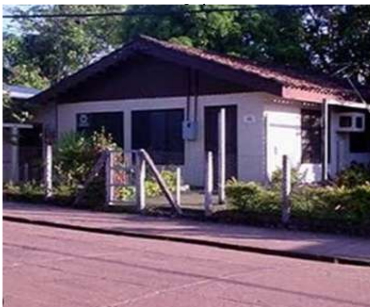
Figura 2 - Casa em Monte Dourado/PA, construída pelo projeto
