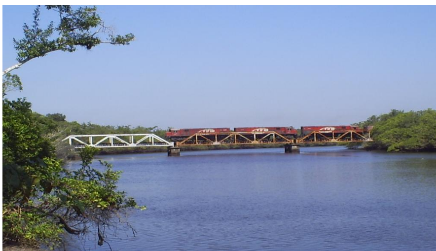
Figura 2: Rio Parati, ponte metálica.
