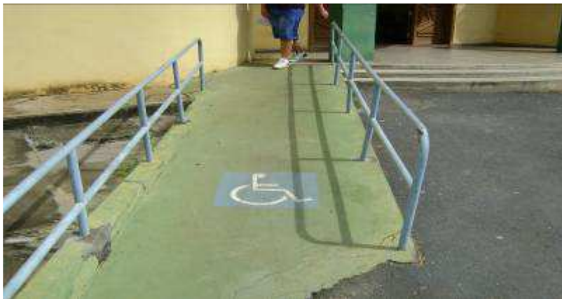
Figura 8 – Rampa de acesso adaptada para biblioteca IFNMG- Campus Januária Fonte: O autor
