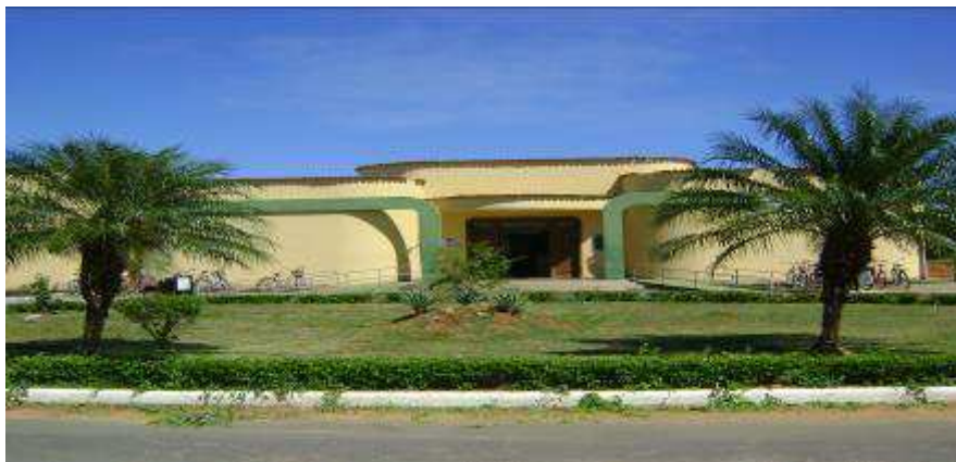
Figura 1 – Biblioteca Saul Martins IFNMG – Campus Januária visão geral entrada Fonte: O autor
