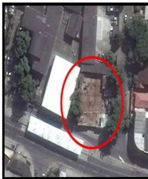
Depois da Demolição
