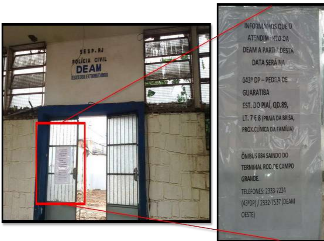
IMAGEM 12: Prédio da DEAM-Oeste em reforma
