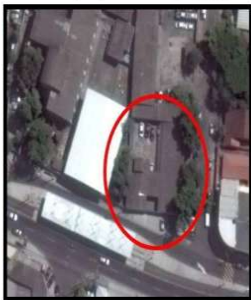
Antes da Demolição
