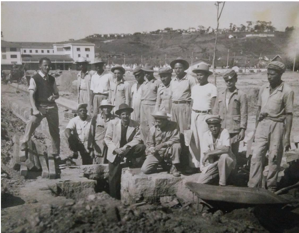
Imagem 1.7 “Construção da rede telefônica subterrânea” 20/08/1948.
