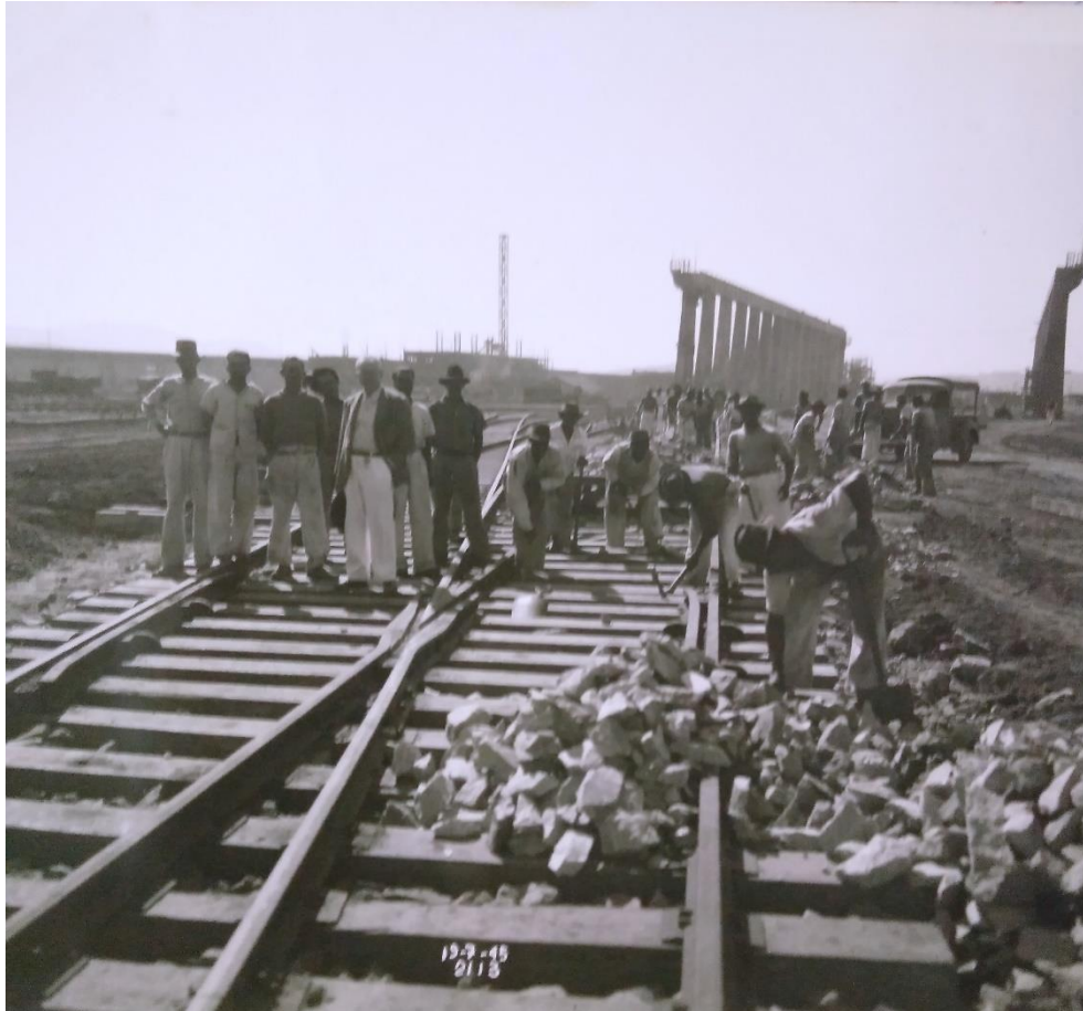
Imagem 1.6 “Construção de Linhas Férreas da Aciaria” 19/07/1945.
