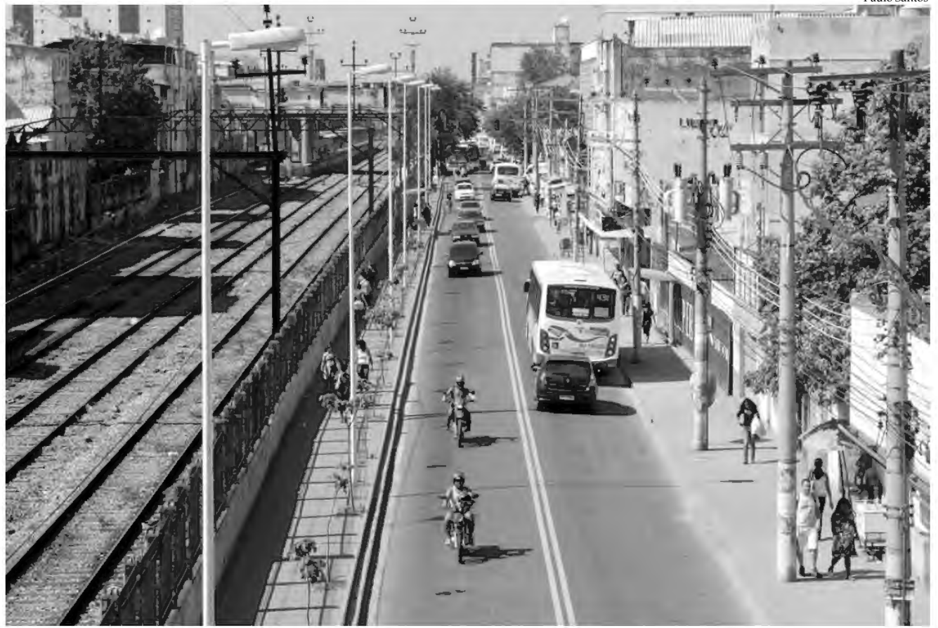
As retenções, segundo motoristas ouvidos pelo CL, serão frequentes na Rua Bernardino Mello porque a via ficou mais estreita com o alargamento do passeio público
