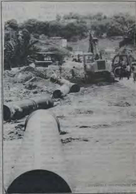
Construção da Adutora Principal da Baixada, com 600 milímetros de diâmetro, na Av. Automóvel Clube, em Belford Roxo
