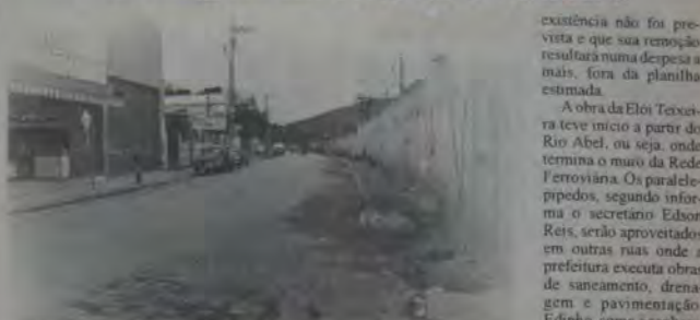
As obras de drenagem e pavimentação da Rua Elói Teixeira trarão grandes benefícios para a população de Queimados.
