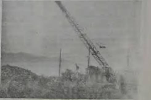
A máquina destinada a fazer a limpeza de um valão na Rua Diamantina encontra-se parada há cerca de 30 dias.
