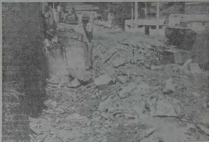
EFOS — 1978 — ESCAVAÇÕES, SANEAMENTO E PAVIMENTAÇÃO DAS RUAS VÊNUS E MERCÚRIO — MESQUITA
