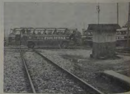
Ferrosas, as passagens de nível existem em grande quantidade ao longo da LINHA AUXILIAR e já provocaram inúmeros acidentes.
