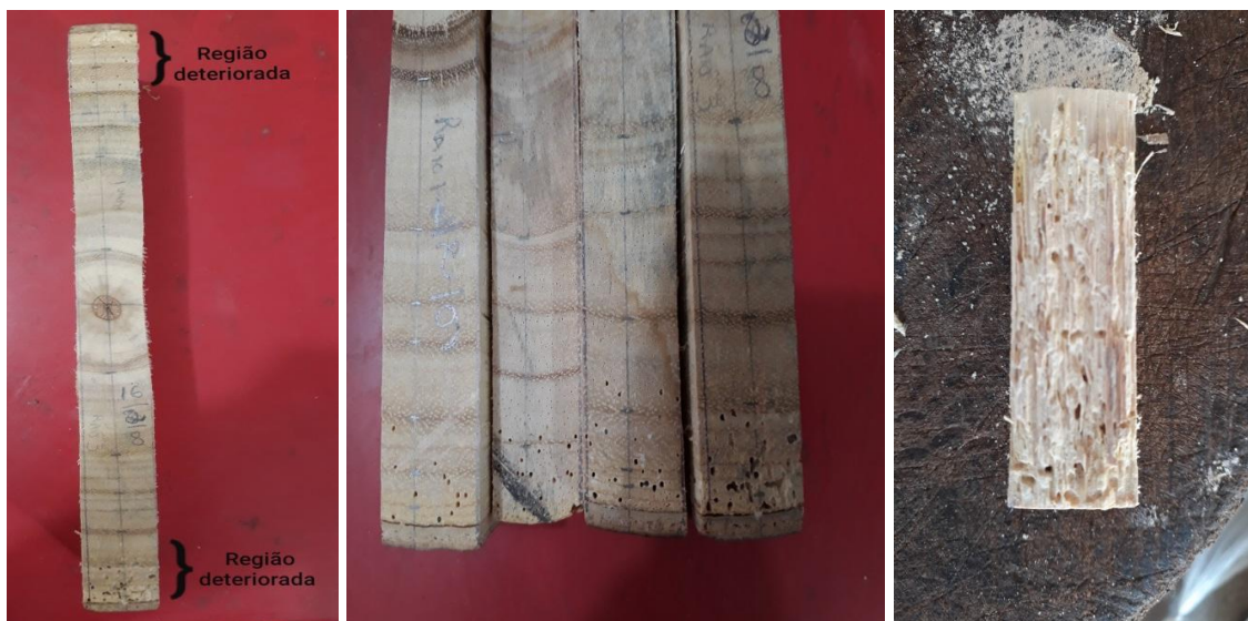
Figura 18. Regiões aparentemente deterioradas.
