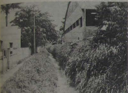
Rua Maxambomba, no centro de Nova Iguaçu, com suas margens construídas, dificultando seriamente os trabalhos de limpeza.
