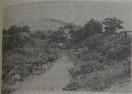
Canal Botas, em Heliópolis, onde são vistas algumas construções ilegais em suas margens, que impedem as necessárias drenagens.
