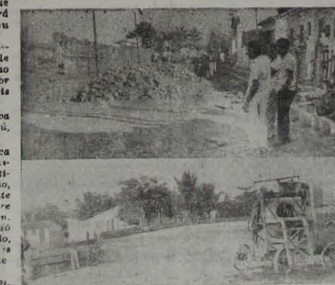
Ao alto, calçamento em execução na rua Manoel Teixeira, em Com. Soares. Em baixo, a ponte, em vias de conclusão, ligando o quilômetro 10 à Estrada de Madureira. São obras que beneficiarão grande parte da população iguaçuana.
