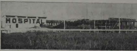
A construção do Hospital está em franco desenvolvimento. Será uma casa hospitalar das mais modernas do E. do Rio
