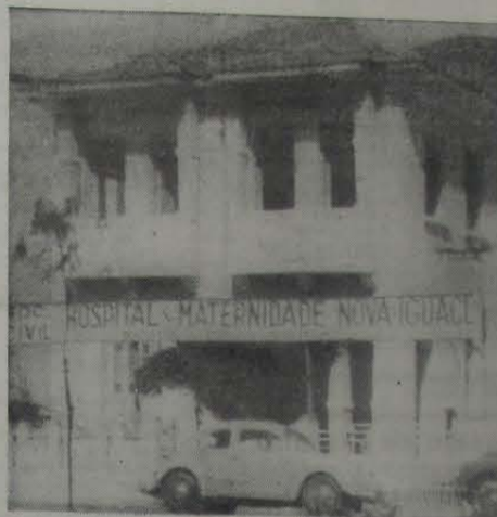
Esta é a sede provisória do Hospital e Maternidade Nova Iguaçu, em pleno funcionamento na r. Bernardino Melo, 2345
