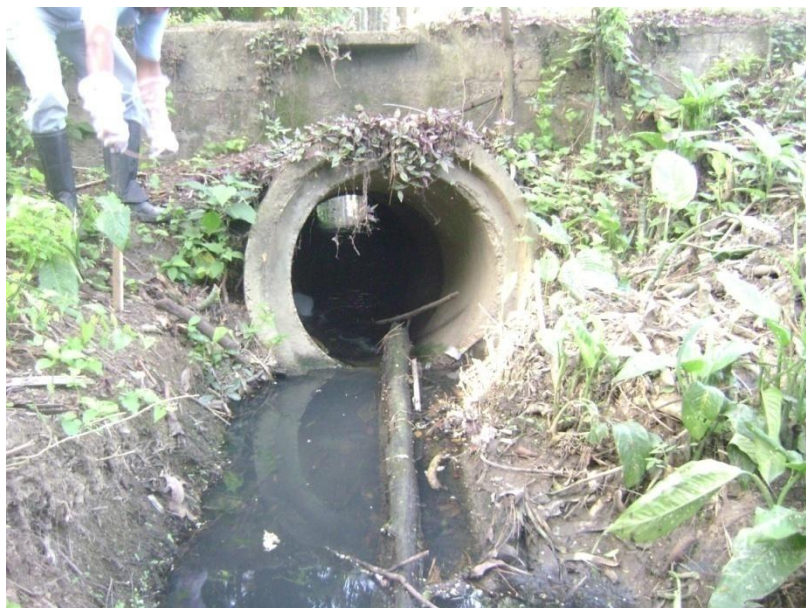
Figura 9: Galeria atual do canal retificado do córrego Açu, composta por uma manilha.
