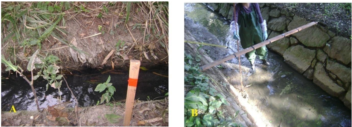
Figura 17: (A) Margens/laterais da calha cobertas por sedimentos; (B) Margens livres de sedimentos.
