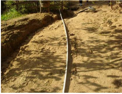
Figura 16: Captação de água
