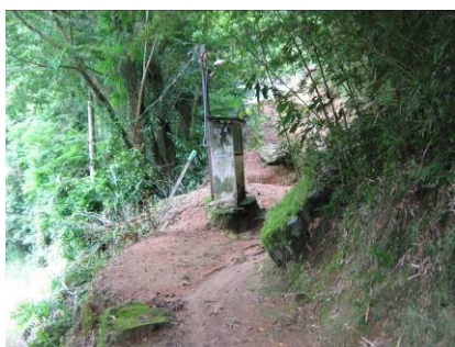
Figura 13: Erosão do solo
