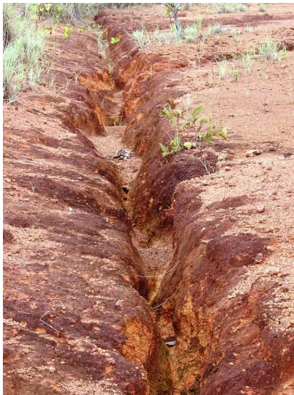
Figura 21. Fossa formada por processos erosivos. Fonte: Linha de Transmissão Paracatu 4(2007).
