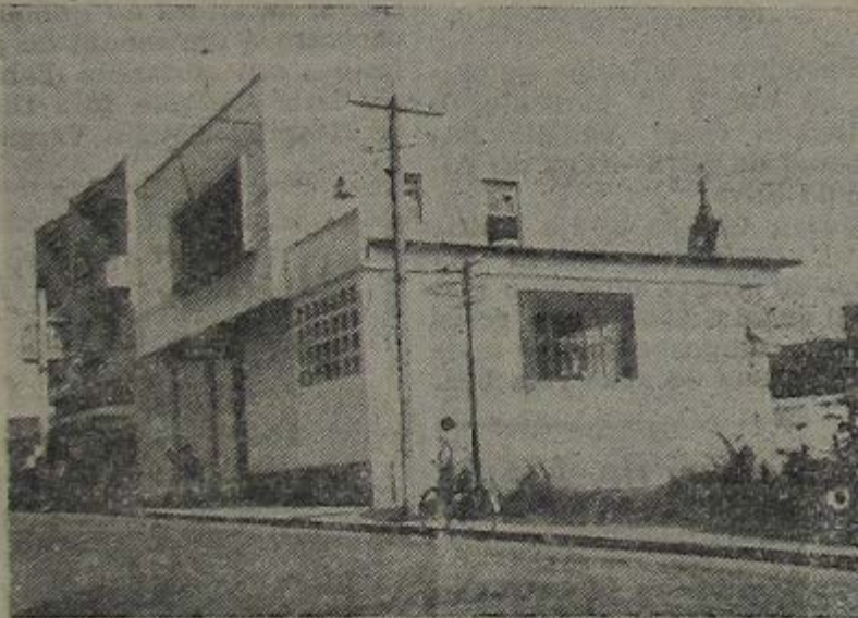
Foto 14 - Novo edifício dos Correios e Telegrafos de Nova Iguaçu. Ed.1843 (1950-1951)
