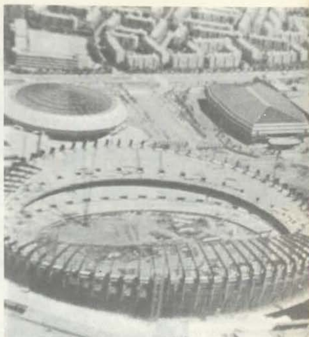
O estádio (em construção) onde se realizarão os próximos Jogos Olímpicos de Seul
