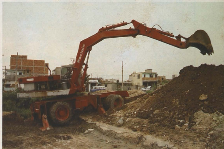
Obras de saneamiento básico - (Brasil)
