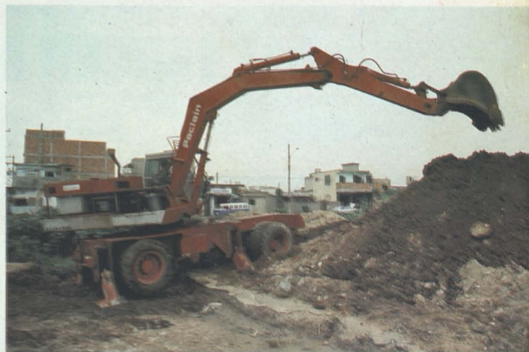
Obras de saneamiento básico - (Brasil)
