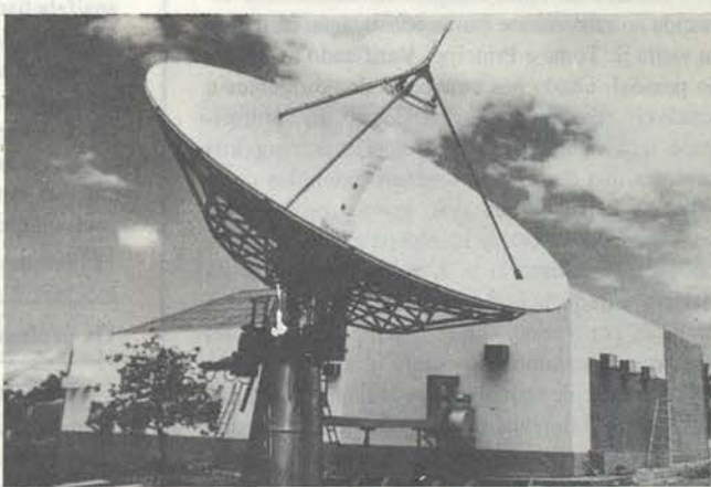
Estação Terrena de S. Marçal. Esta moderna central de telecomunicações, inaugurada em Novembro de 1980, com uma potência de recepção de 4095 megawatt, desfez muito da solidão das ilhas ao facilitar extraordinariamente a rede telefónica com o mundo e permitir a instalação de telex. Através de satélite, três canais directores fazem a ligação com a Estação de Sintra, em Portugal, donde é distribuído todo o tráfego; e três outros circuitos entrarão brevemente em funcionamento, dois com Angola e um com a Argélia. O financiamento foi argelino e a tecnologia japonesa, funcionando a Estação com técnicos nacionais formados na Argélia e Portugal.
