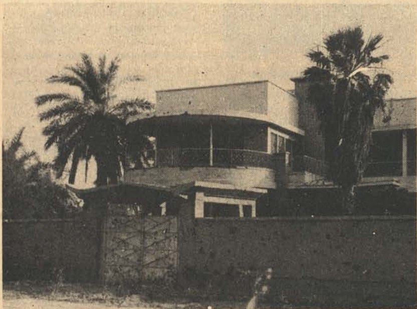
En algunos barrios de Basra aún hay casas sin reconstruir, y en la avenida costera trabajan las aplanadoras, mezcladoras de hormigón y bulldozers
