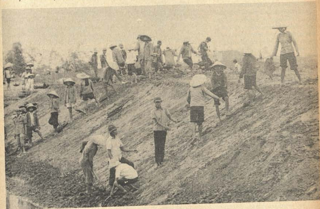
Construcción de diques. Toneladas de tierra son movidas a mano
