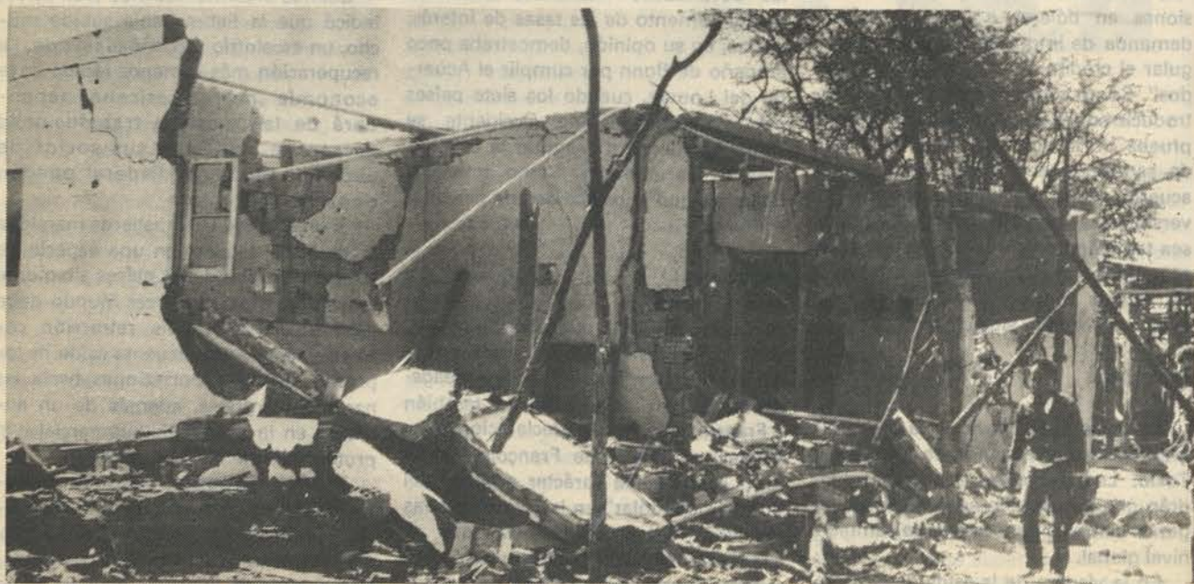
Muerte y destrucción son las secuelas de la invasión iniciada el 6 de setiembre
