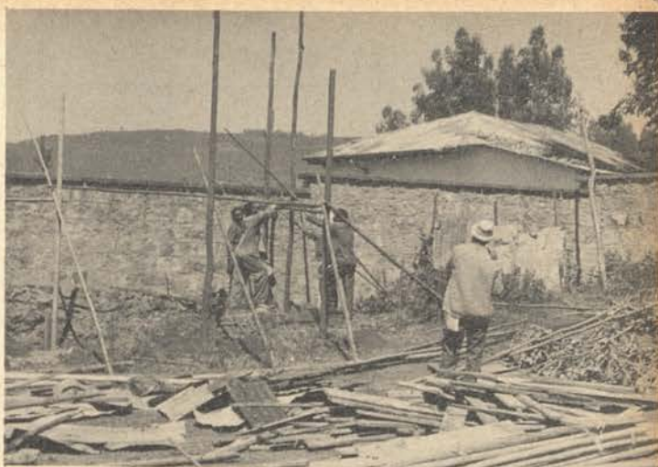
Con trabajo voluntario se levanta una carpintería
