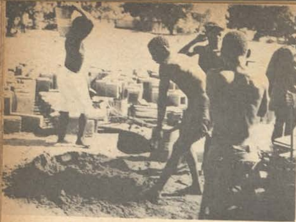
La autoconstrucción de las casas populares permite mejor solución para los problemas de viviendas
