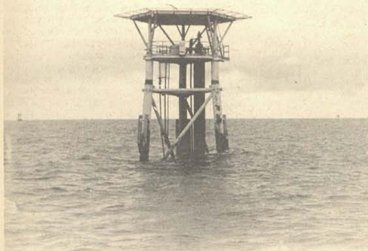
Uno de los 130 pozos en las costas de Cabinda
