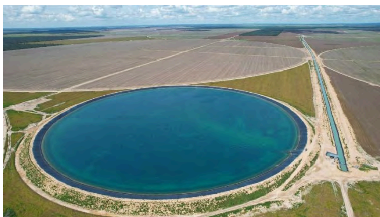
Figura 61 - Reservatório para irrigação de soja em Luís Eduardo Magalhães
