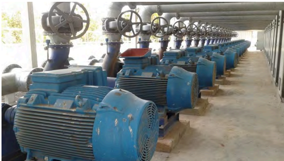
Figura 27 - Bombas para retirada de água superficial
