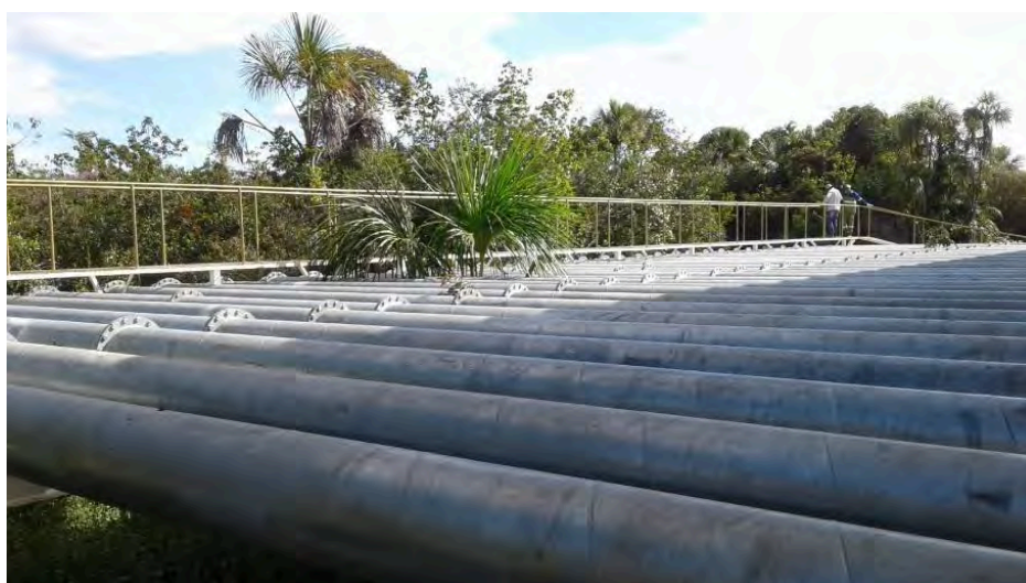
Figura 28 - Instalação de equipamento para retirada de água superficial
