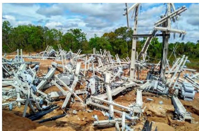
Figura 23 - Instalação elétrica destruída Fonte: Mais Oeste (2017).
