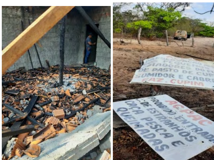
Figura 66 - Rancho de Fecho de Pasto em Correntina destruído
