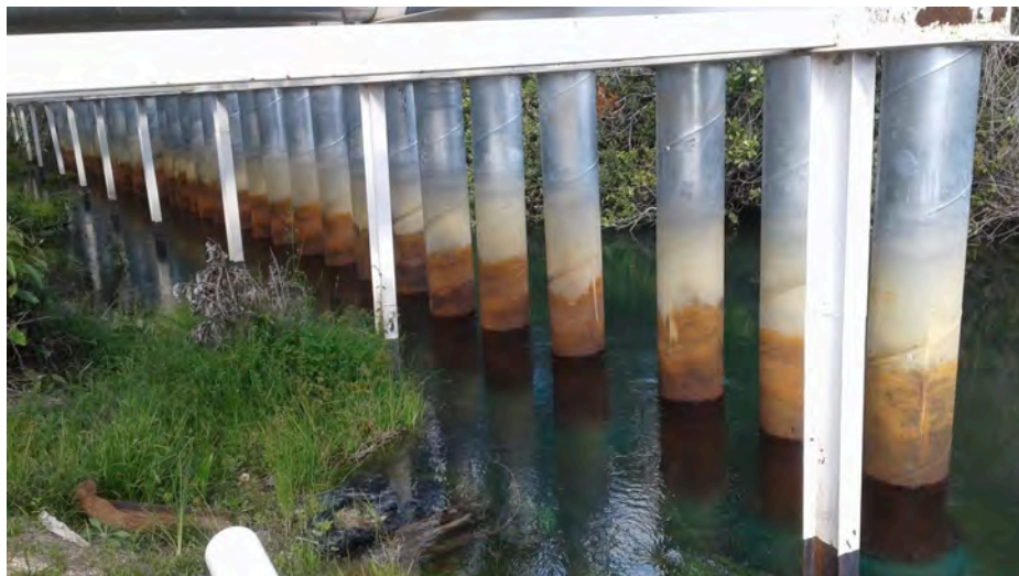
Figura 29 - Equipamentos para retirada de água superficial com marca de baixo nível de água Fonte: Imagem de circulação em rede social (2022).
