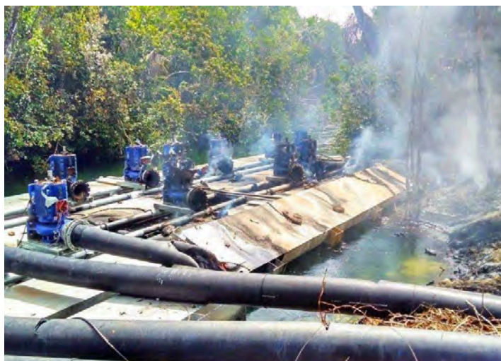
Figura 22 - Bombas de extração de água destruídas na fazenda Igarashi Fonte: Mais Oeste (2017).
