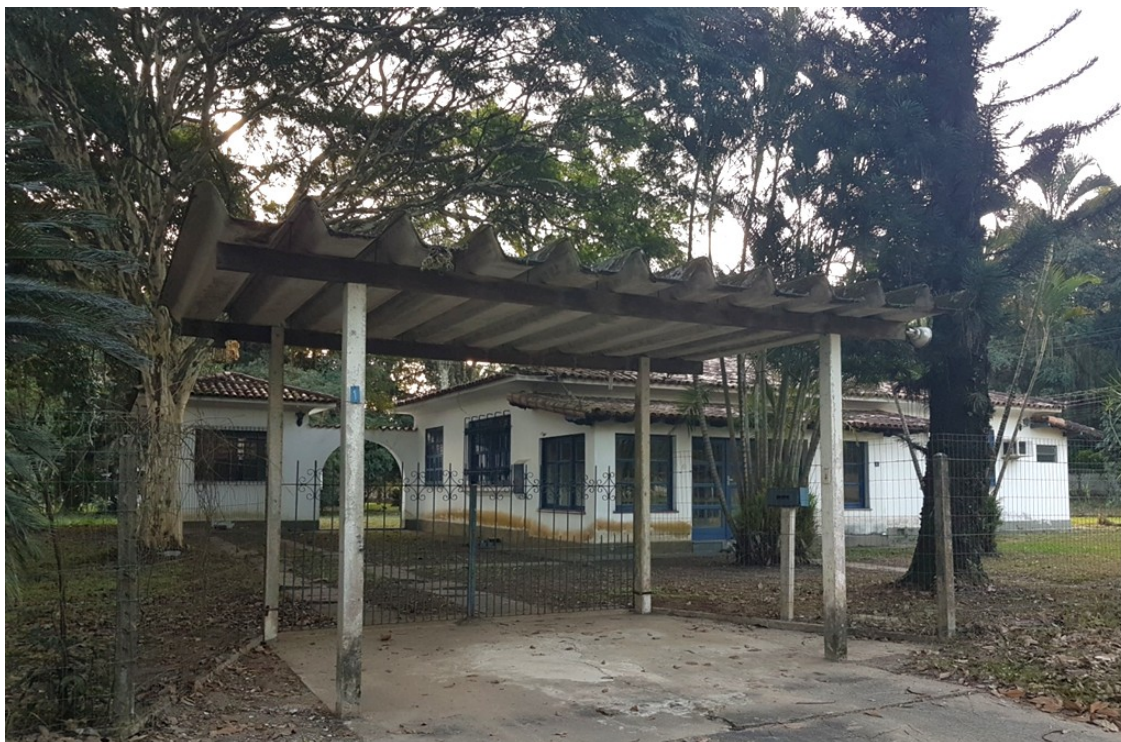
Figura 2 - PNR localizado no bairro Ecologia. Alguns PNRs ainda preservam o estilo Neocolonial, o mesmo utilizado na construção do campus da UFRRJ em Seropédica.
