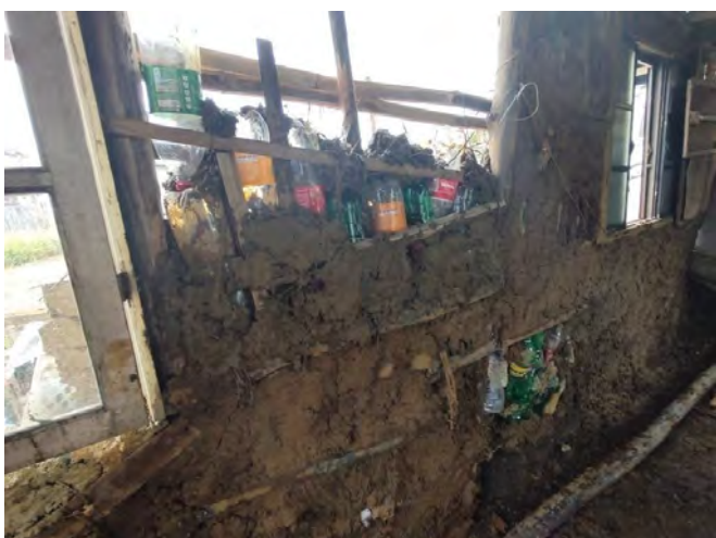
FOTO 2: Construção de barraco usando retalhos de madeira, garrafas pet e barro. Detalhes internos.
