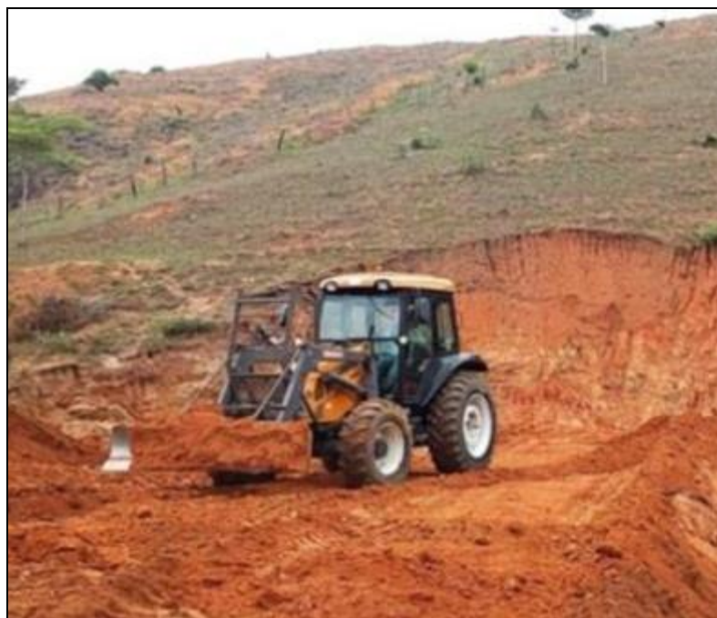
Figura 14 - Prática de corte e aterro realizada por agricultores familiares de Nova Friburgo. Fonte: Arquivo pessoal.
