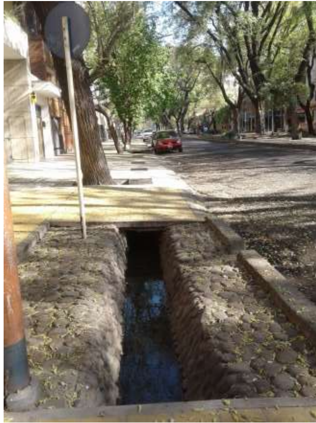
Figura 5. Acequia em uma avenida de Mendoza (Avenida B. Mitre). Fonte: Arquivo Pessoal.
