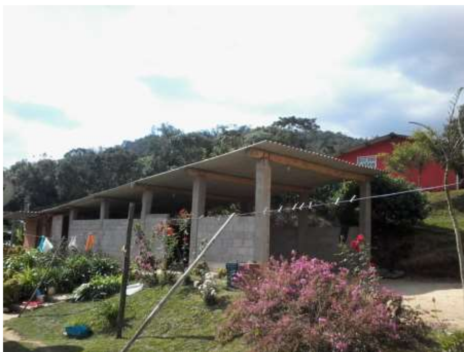
Figura 50. Segundo galpão de recepção de alimentos da Associação Serra Nova. Fonte: Arquivo Pessoal.
