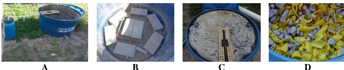
Figura 4 - (A) conjunto de filtros biológicos; (B) tubulação de distribuição do efluente de P2, no fundo falso de P3.1; (C) barreira flutuante de proteção da saída de P3.1; (D) conduítes corrugados picados como recheio utilizado em P3.2.
