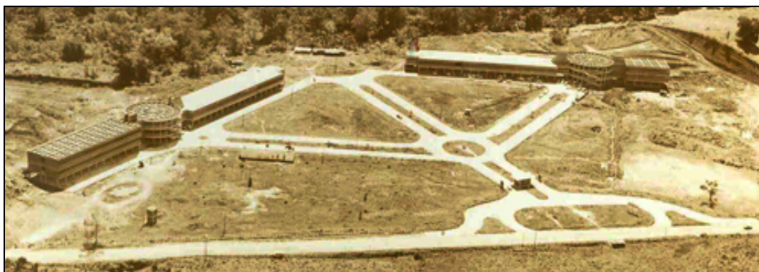
Foto 33 – Vista panorâmica da construção da UESC.
