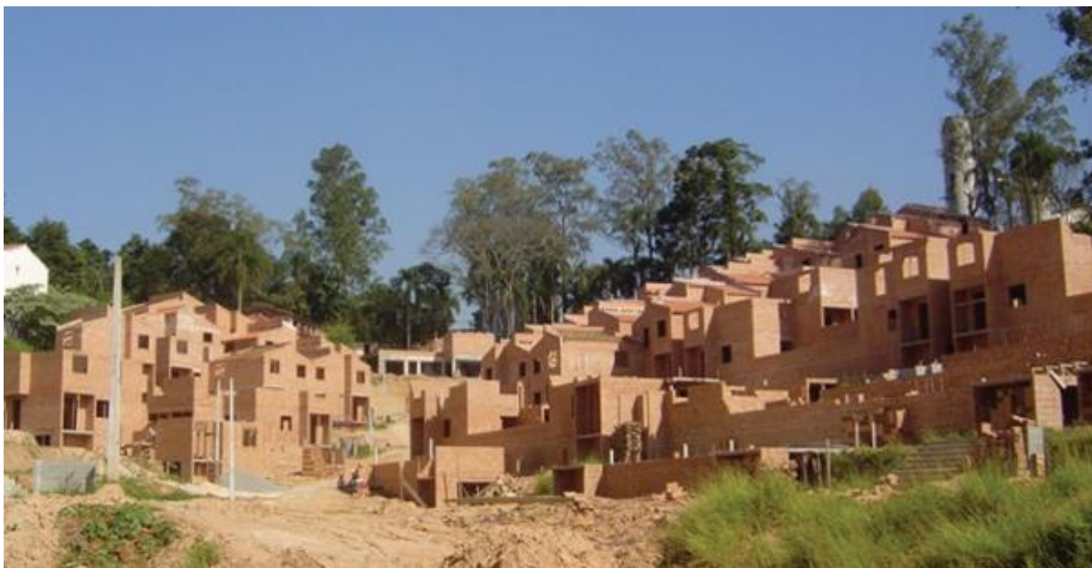
Figura 7 – Construção da moradia definitiva para os moradores que fazem parte do acampamento Comuna Urbana Samambaia , em Mina dos Olhos, SP 91 . Fonte: < http://www.revistaovies.com/artigos/2013/03/a-comuna-urbana/ >. Acesso em: 13 de abril de 2013.
