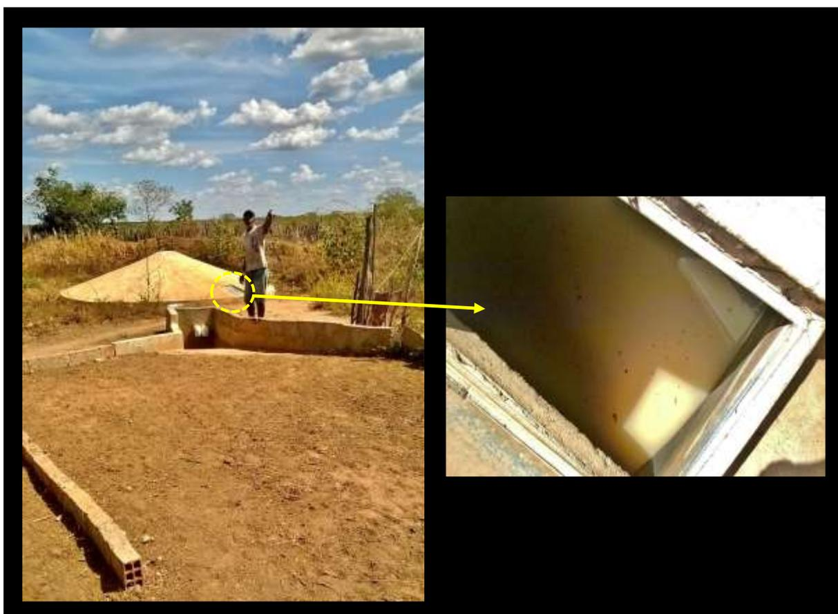
**Figura 37** - Cisterna de enxurrada, com detalhe na água armazenada indicando a sua baixa qualidade e inadequação para consumo humano.
