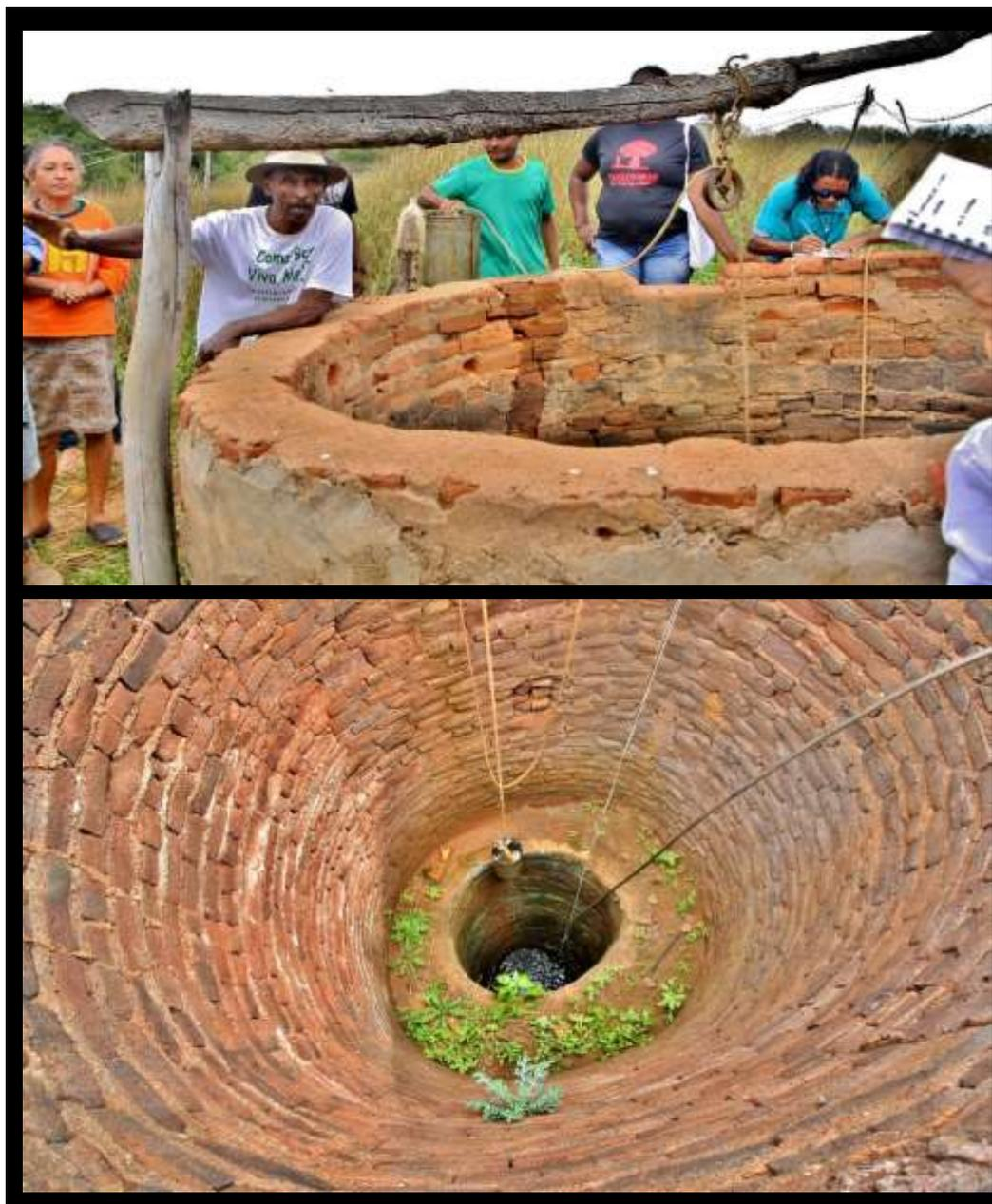
**Figura 34** - Poço amazonas escavado em 1974 na comunidade de Serra do Talhado, em Mirandiba/PE. Elemento central do abastecimento de água durante vários anos, e motivador da construção de barragem subterrânea (**Figura 35**) que lhe estabilizou a vazão. Fotos de agosto de 2016.
