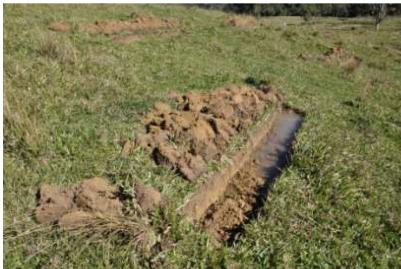
Figura 3. Técnica de restauro rugosidades no solo implantadas no PNSI, Santa Catarina 2013.
