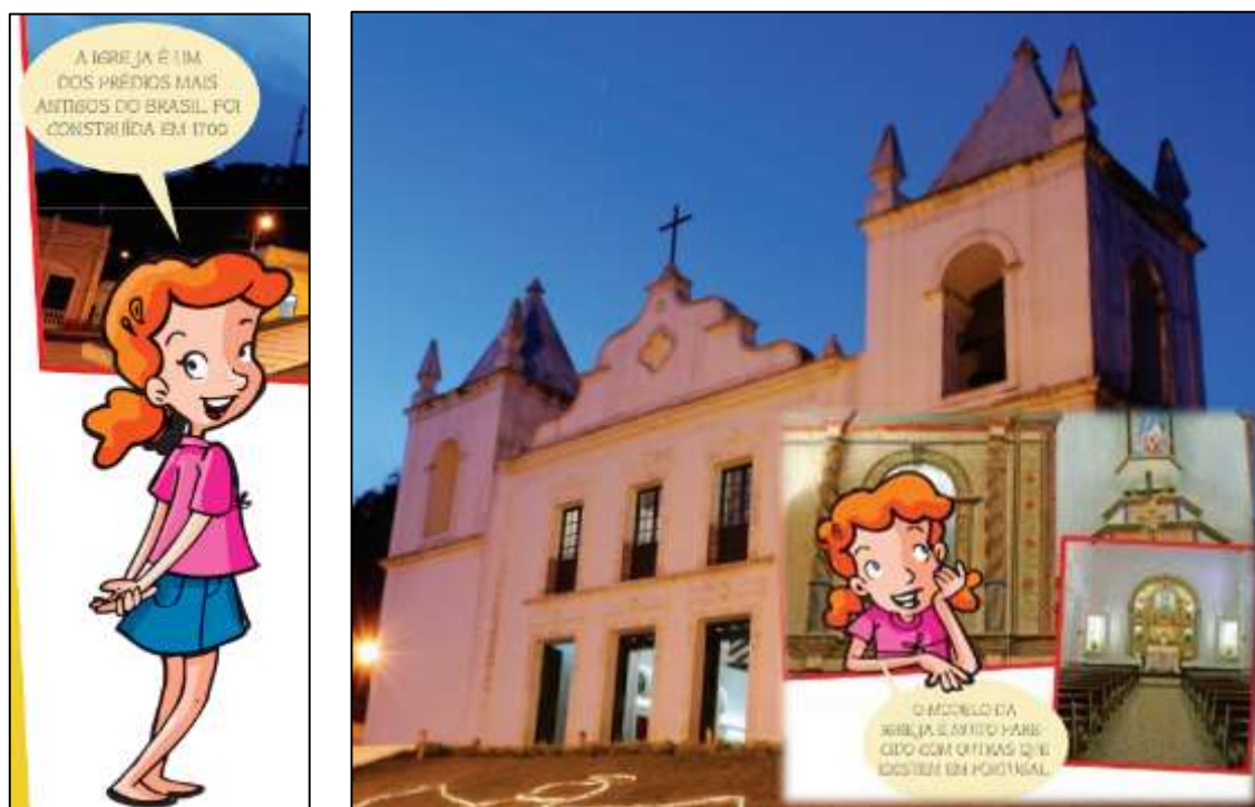
Figura 44 – Igreja N. Sra. da Assunção, construída em 1700 em Viçosa do Ceará
