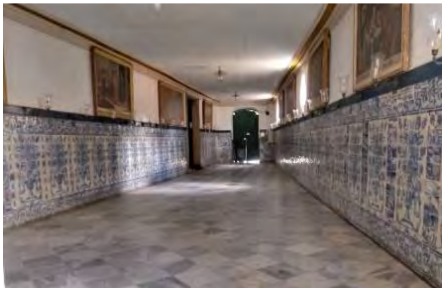
Figura 26. Corredor Lateral. Fonte: Foto da autora, 2020.
