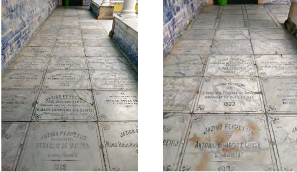
Figura 36. Piso do Corredor do Castro com os Jazigos. Fonte: fotos da autora, 2020
