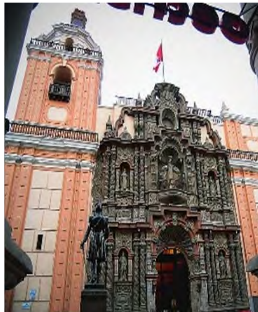
Figura 2 - Fachada da Basílica de N. Sra. de La Merced, Lima - Peru.
