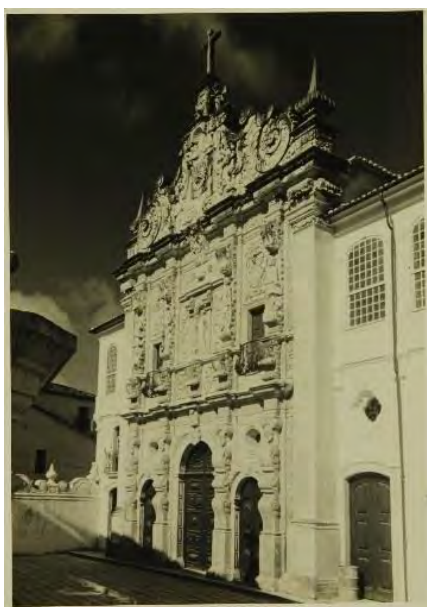
Figura 66. Fachada da Igreja da Ordem Terceira de São Francisco de Assis em Salvador caiada de branco. Fonte acervo do IPHAN.
