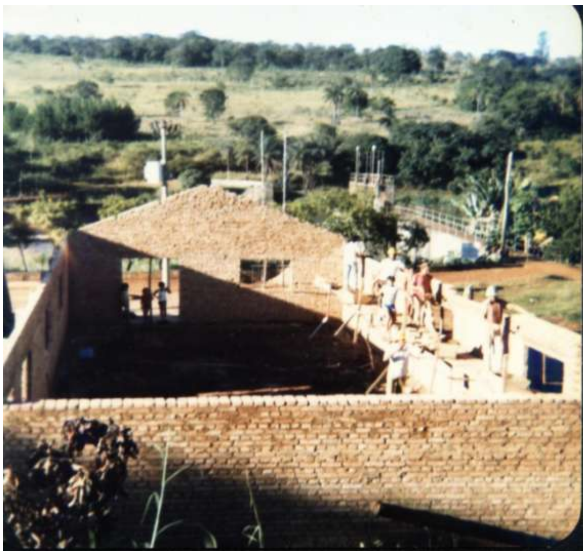
Figura 11: Construção do Galpão da Vila Operadora Pai Joaquim. Fonte: Acervo do Entrevistado (2016)
