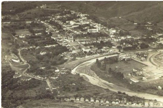
Figura 05: Vista antiga de Mariana (sem data): ao centro, Matriz da Sé e aos fundos a nova ocupação, projetada por Alpoim, com Igreja de São Pedro dos Clérigos ao alto.
