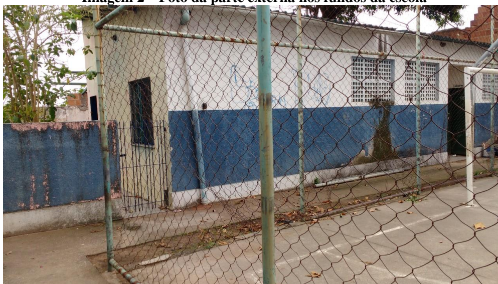
Imagem 2 – Foto da parte externa nos fundos da escola
