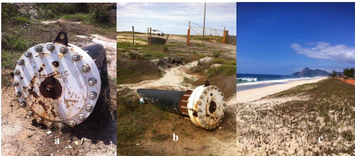
Figura 8: Tubulações do Emissário Submarino (a e b) e (c) Praia de Itaipuaçu, local por onde estão passando essas tubulações enterradas. Fonte: Arquivo Pessoal.
