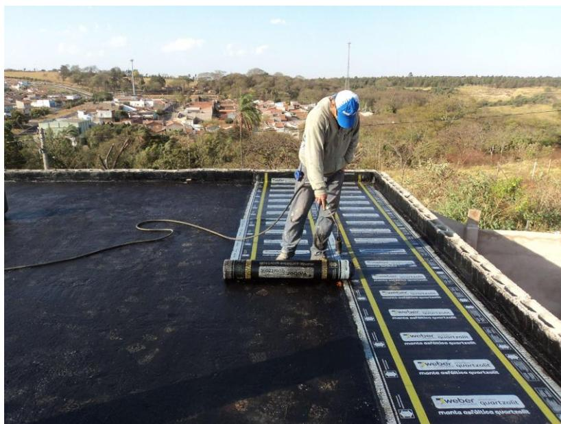
**Figura 19** –Aplicação de manta asfáltica anti raiz. Fonte: IMPERFRAN (2017)
